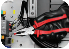
ELÉTRICO ELECTRICO | ELECTRIC
