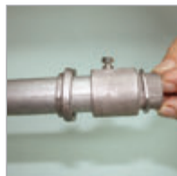
Add the conduit into the accessory and press the screw. Introducir el electroducto en el accesorio y apretar el tornillo.
