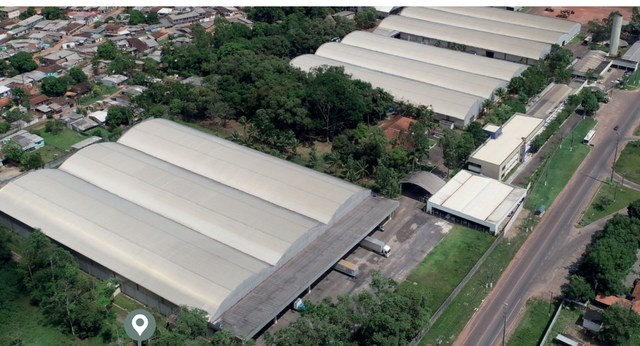
Unidade Fabril BELÉM | BELEM'S Plant | Unidad fabril BELÉM
